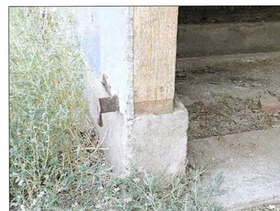
NORTH DOOR JAMB
